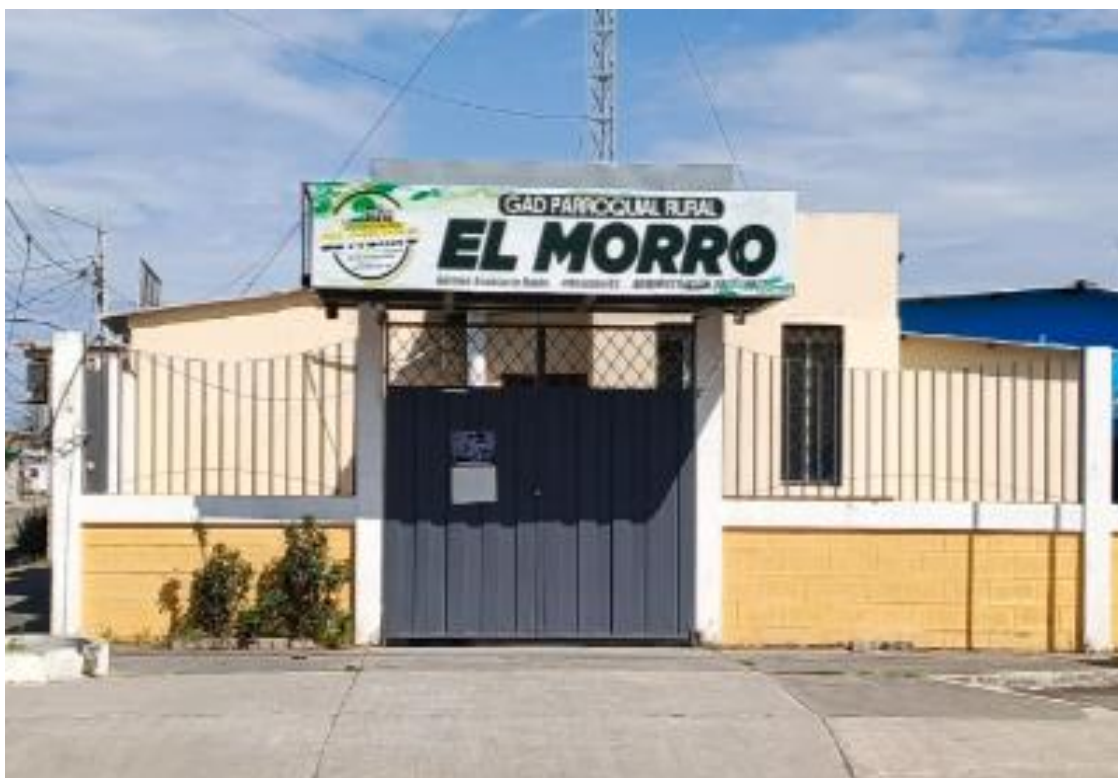
Ilustración. N° 2 Edificio del Gad Parroquial El Morro Fuente: GAD El Morro Elaborado: Equipo Consultor PDyOT 2023 – 2027
