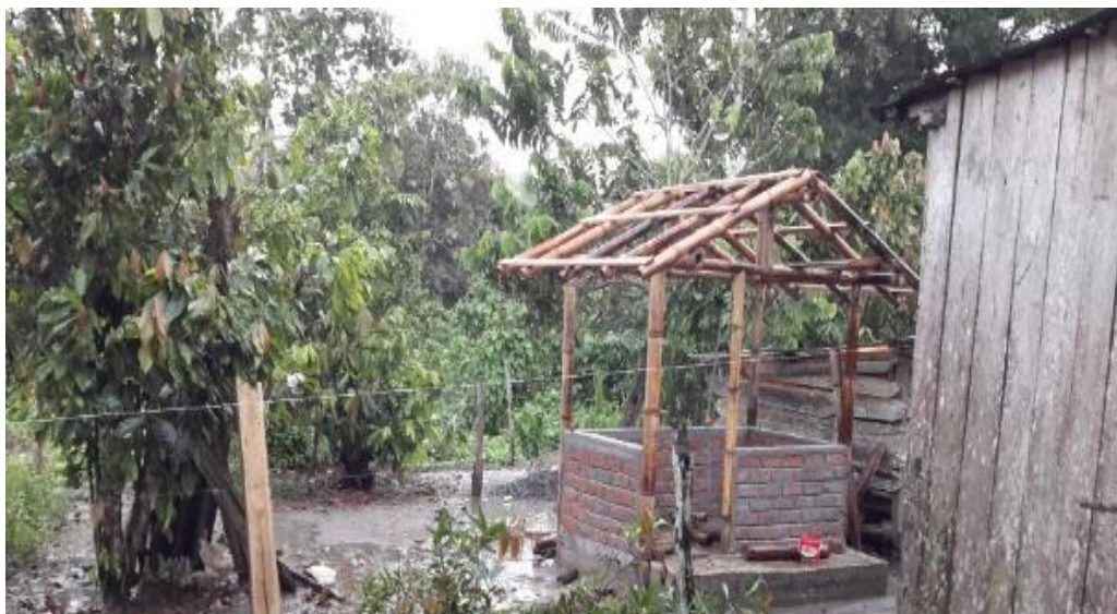
Foto N° 26 Construcción de letrinas. Parroquia Rocafuerte.
