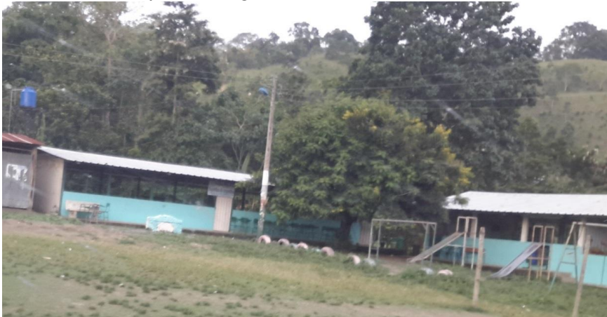
Foto N° 9 Escuela República de Argentina cerrada. Altamira.
