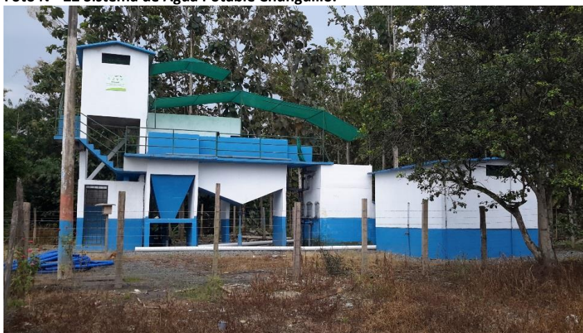
Foto N° 22 Sistema de Agua Potable Chunguillo.
